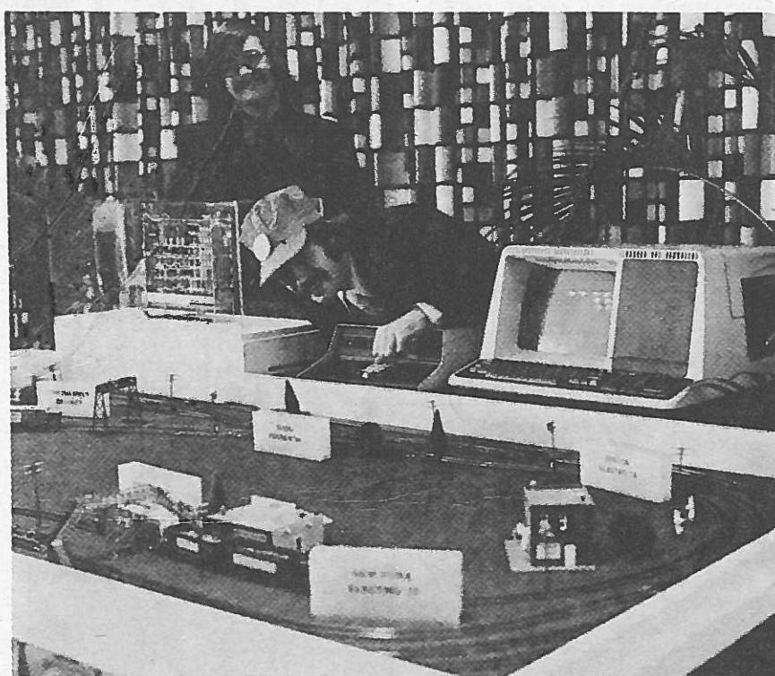
Obr. 92. Model železnice řízený mikropočítacem LSI-11 firmy Digital Equipment Corp. Byl předveden na konferenci IEEE Electro 76 v Bostonu
